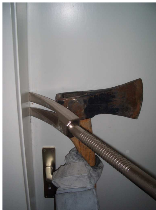
Aufbrechen durch hebeln über das Widerlager
