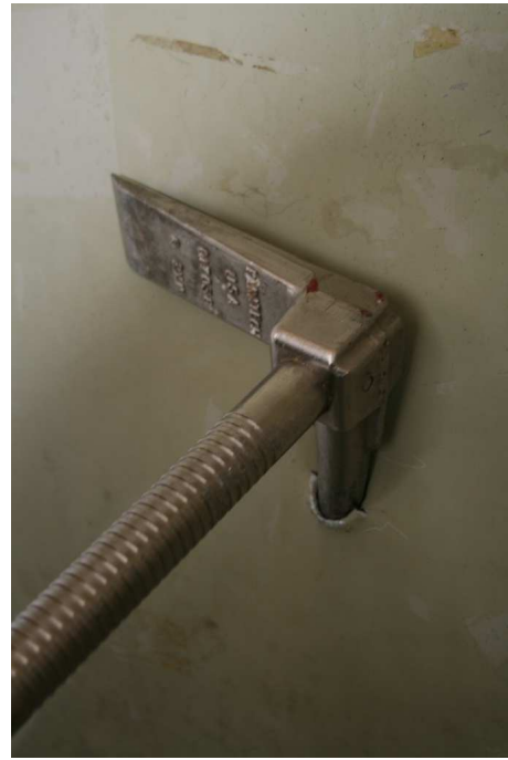
Vorbereiten der Anfangsöffnung durch
